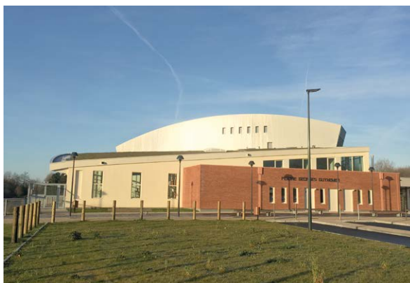
Piscine de Saint-Pol-sur-Mer (59) © Eiffage Énergie Systèmes
