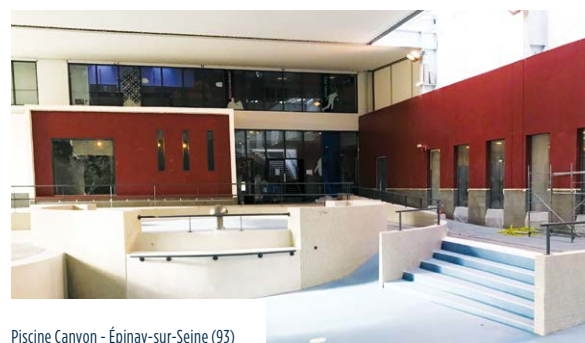
Piscine Canyon – Épinay-sur-Seine (93)
